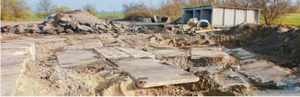
Abb. 2: Nach dem Rückbau der Asphaltmischanlage im Jahr 2014 musste die Platzbefestigung mit Betonteilen, Asphaltdecke und Garagentrakt entfernt werden. Im Bildhintergrund ist die Zufahrt zum Platzgelände zu sehen. (Foto: DEUTAG Ost)
