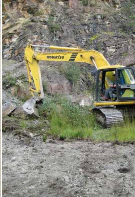
Abb. 13: Baggereinsatz zum Abziehen des Oberbodens (Foto: BSO).
