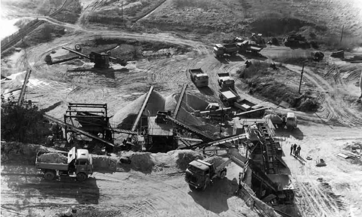
Abb. 4: Aktiver Tagebau Remschütz, hier: verschiedene Muldenkipper und Aufbereitungsanlage (Foto: Hecht 1978).
