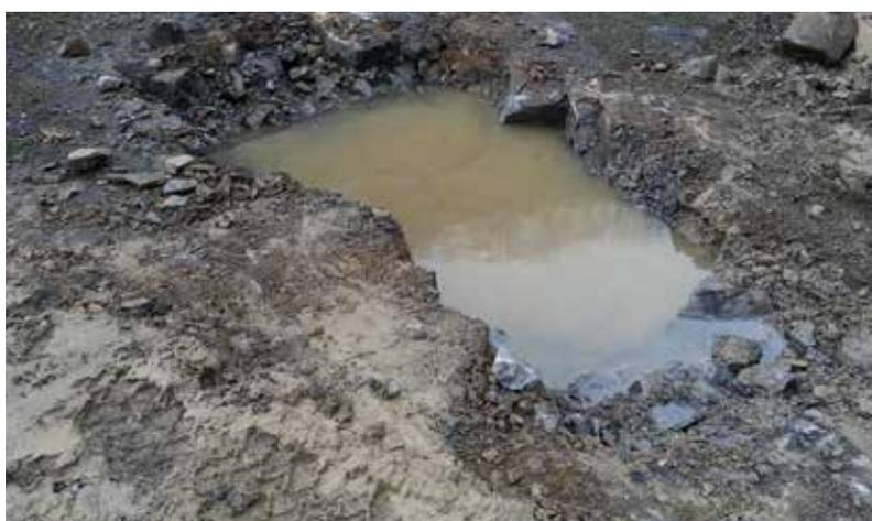
Abb. 20: Hergestellter Felsstümpel unter dem Einsatz eines Stemmmeißels (Foto: Ilona Jentschke).
