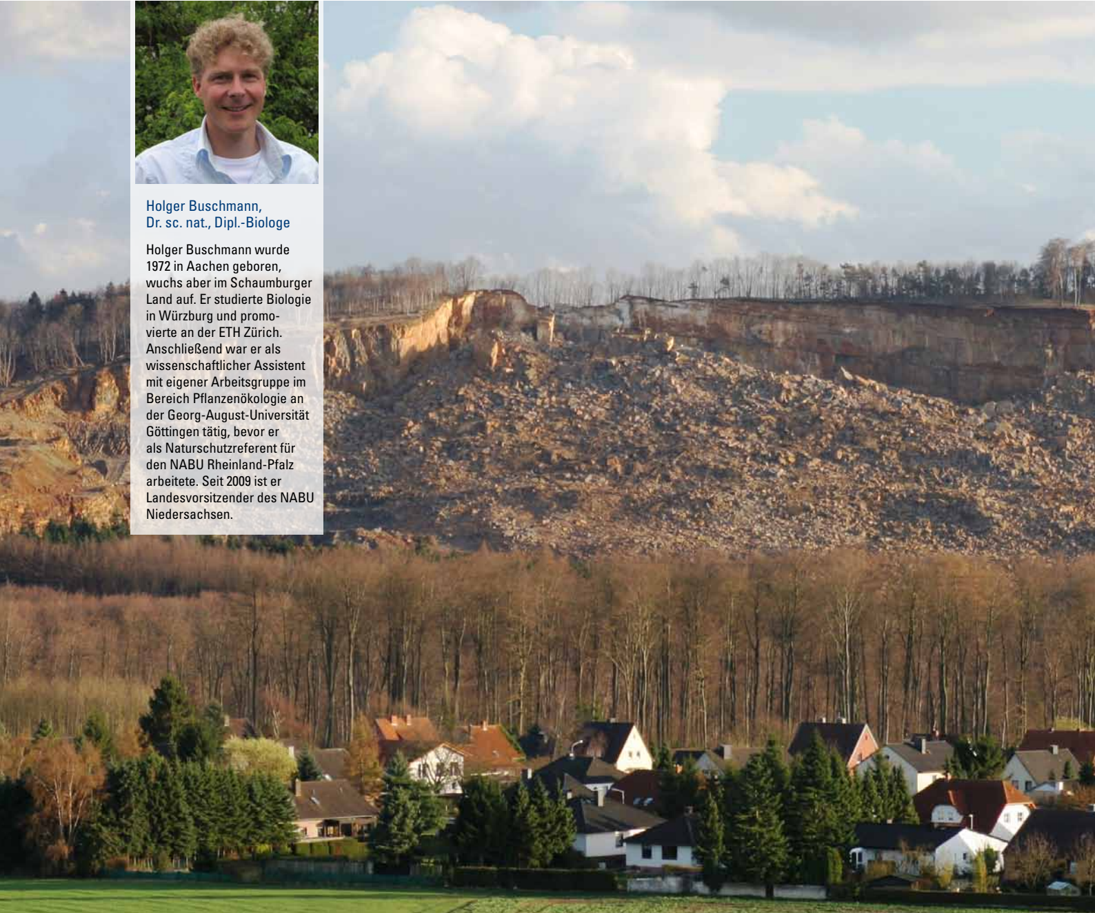
Abb. 1: Der Kammabbruch am Messingsberg im Steinbruch Steinbergen (Foto: Bruno Scheel)
